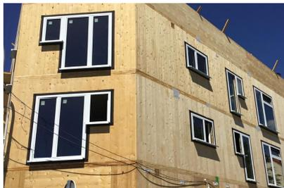
\*Paneles estructurales de CLT
